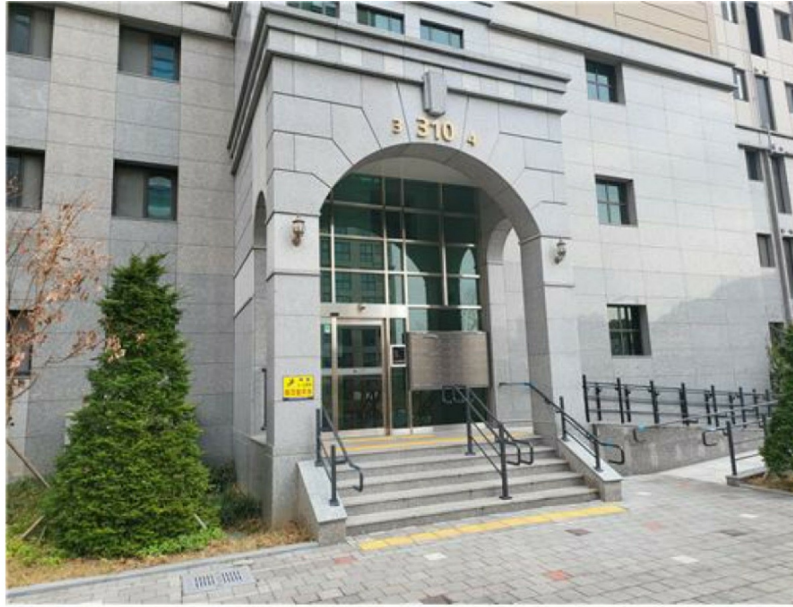
[1층 공동 출입구]
