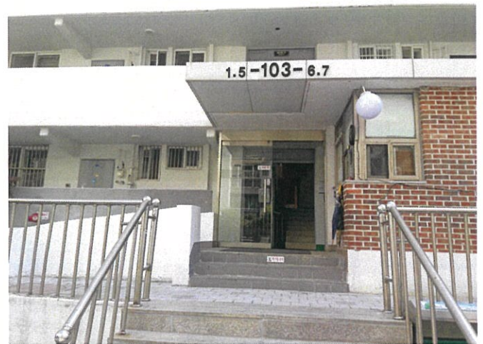
본건 1층 출입구
