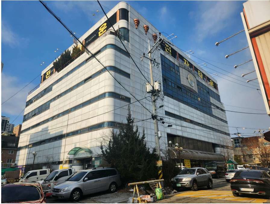
본건 건물전경(본건 동측에서 촬영)
