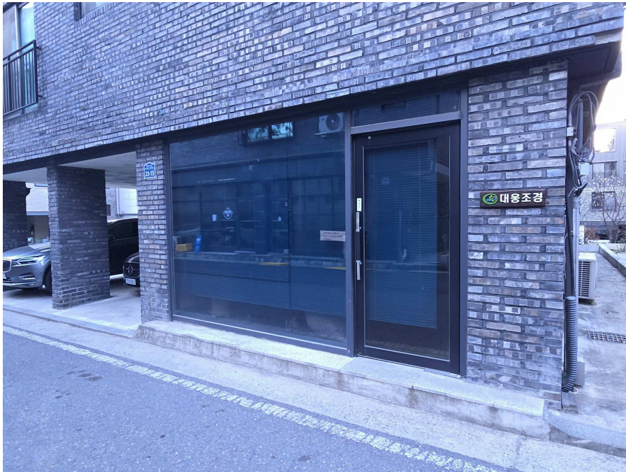
[본건 건물 1층(근린생활시설)]
