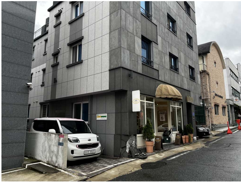
본건 건물(1층 카페)
