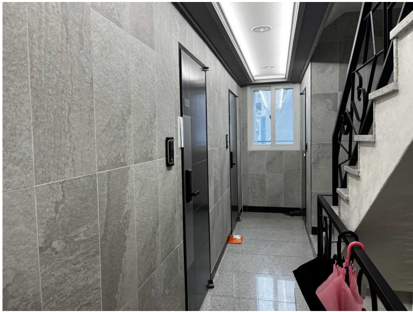
본건 건물 3층
