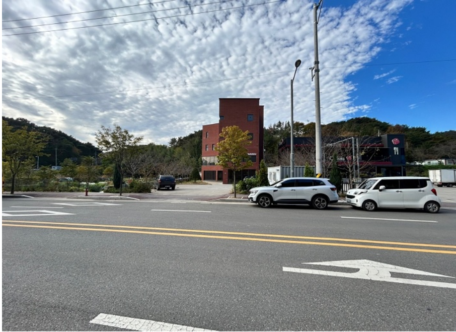
[ 기호 1) 북동측 전경 ]
