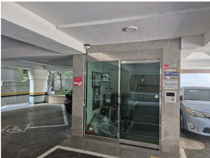
본건 소재 건물 1층 주출입구
