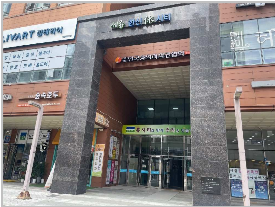
[대상물건 1층 주출입구 전경]
