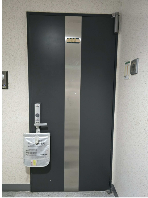
대상물건 일련번호1 출입문 전경
