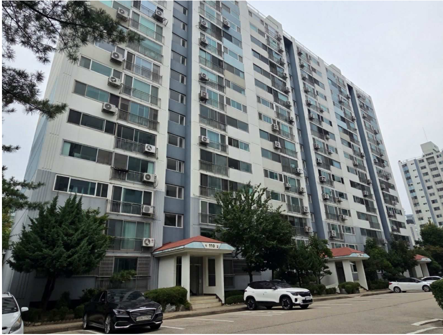
[본건 아파트 전경(남측에서 촬영)]
