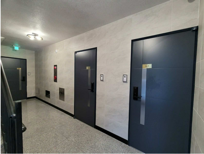
기호(2) 3층 전경
