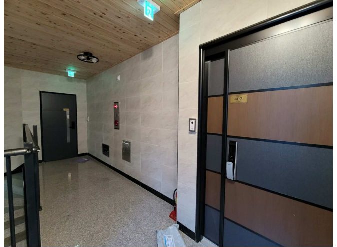
기호(2) 4층 전경
