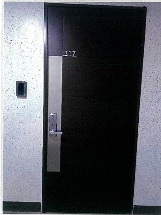
[대상물건 일련번호1 출입문 전경]
