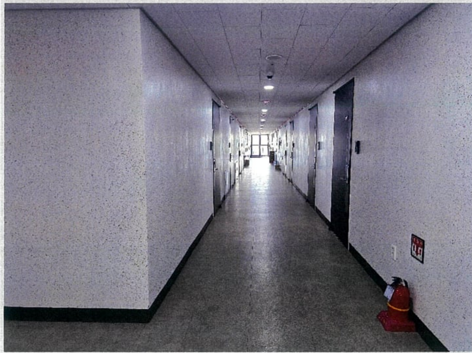
[대상물건 일련번호1 복도 전경]
