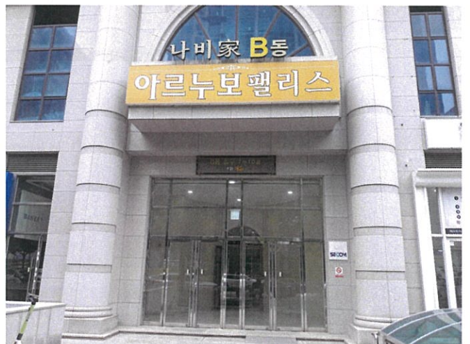
본건 1층 출입구 촬영
