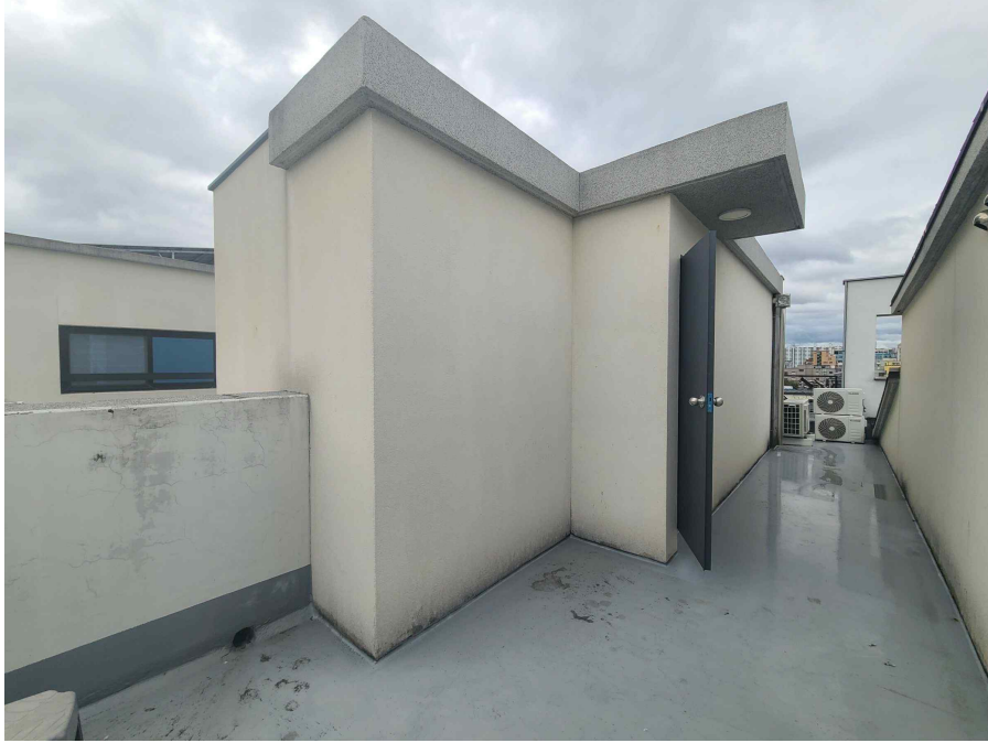
본건 건물 옥상 계단실 및 기계실 전경
