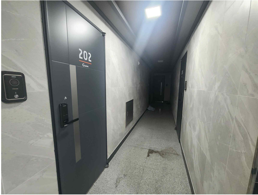
본건 건물 2층 복도 전경
