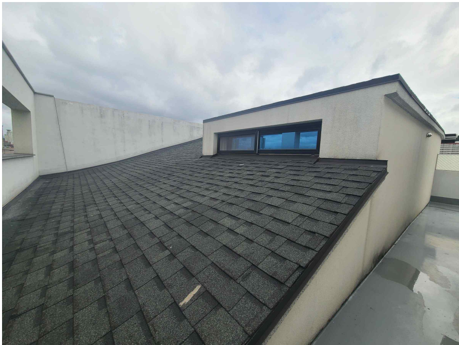
본건 건물 4층 누다락 외부 전경
