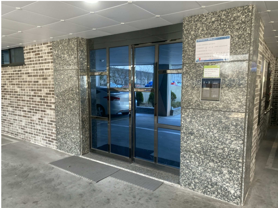
본건 1층 출입문
