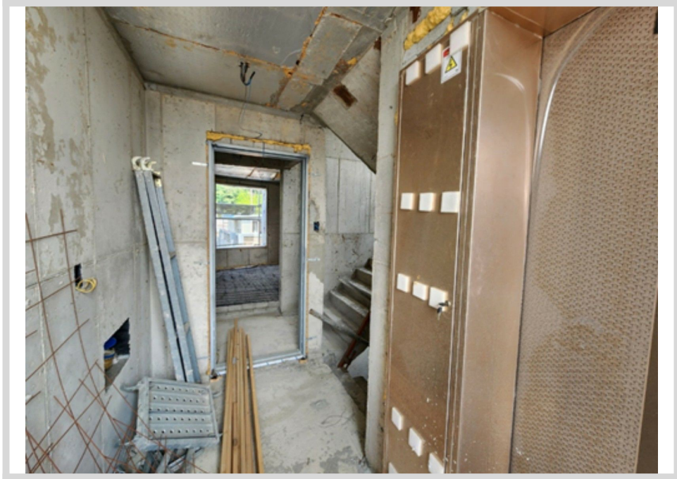
본건 5층 내부 전경
