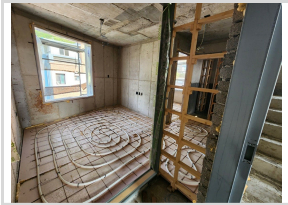
본건 4층 내부 전경
