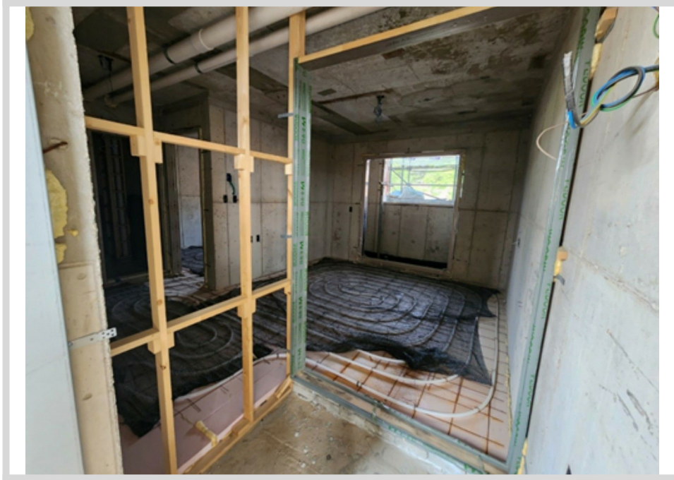
본건 3층 내부 전경
