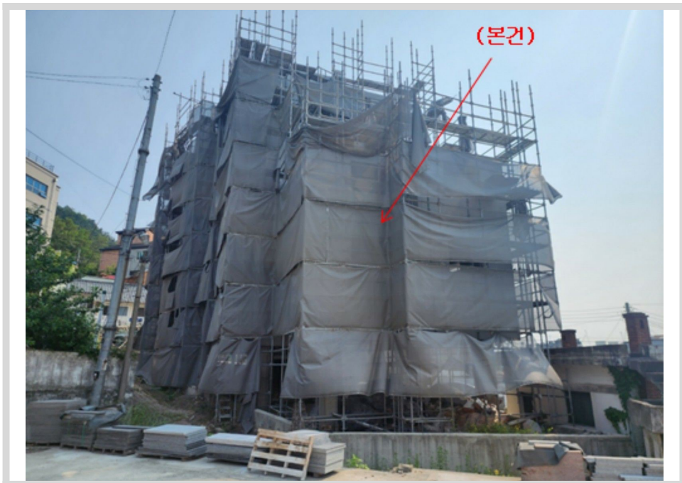
본건 전경 - 본건 북측에서 촬영
