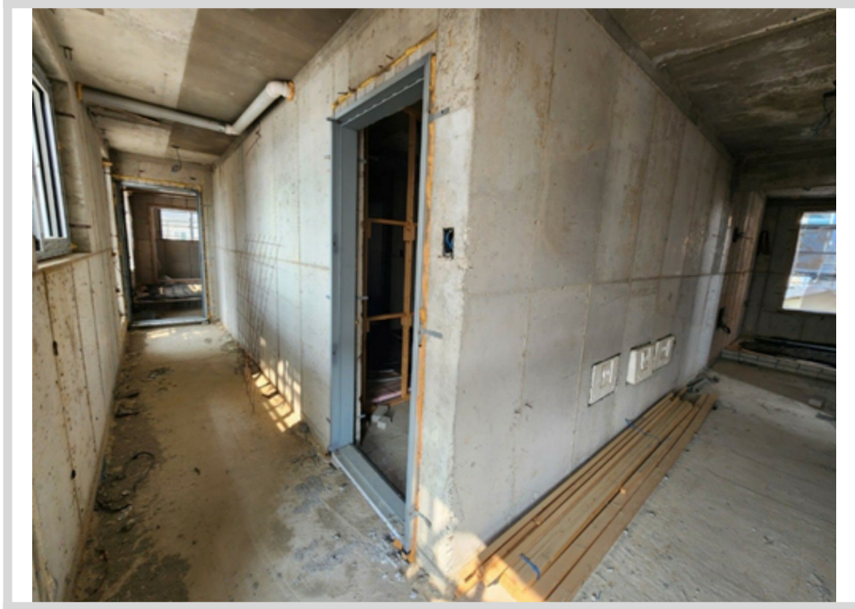
본건 2층 내부 전경
