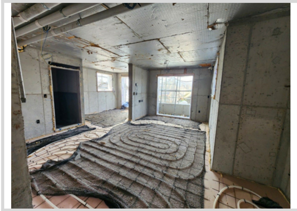
본건 5층 내부 전경
