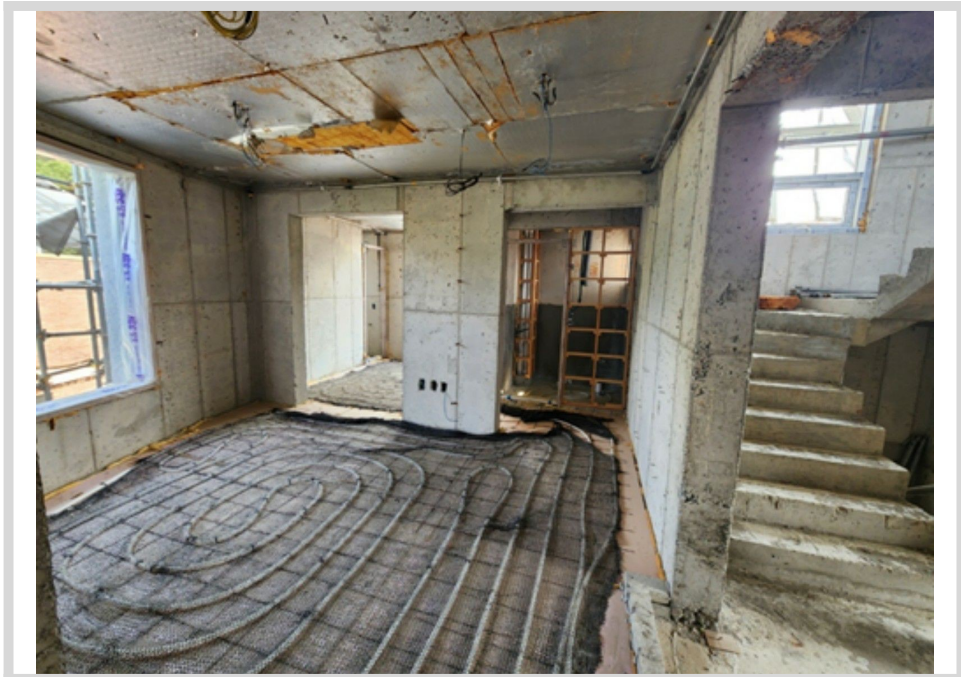
본건 5층 내부 전경
