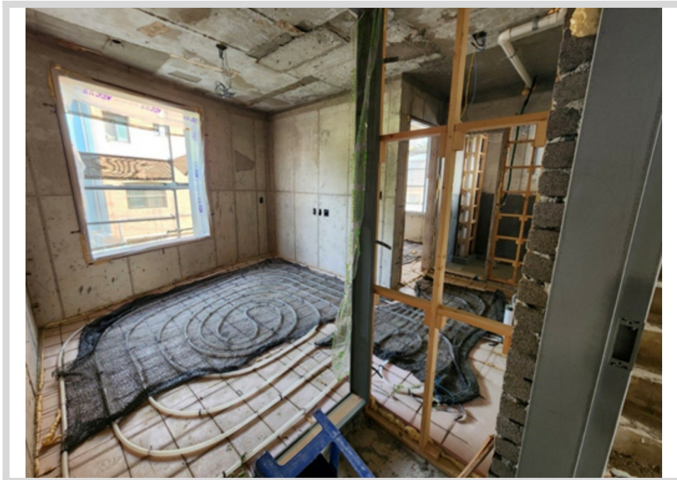
본건 3층 내부 전경
