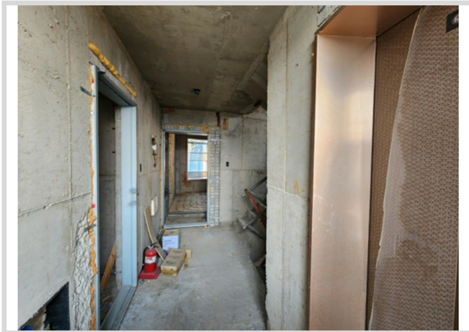
본건 4층 내부 전경
