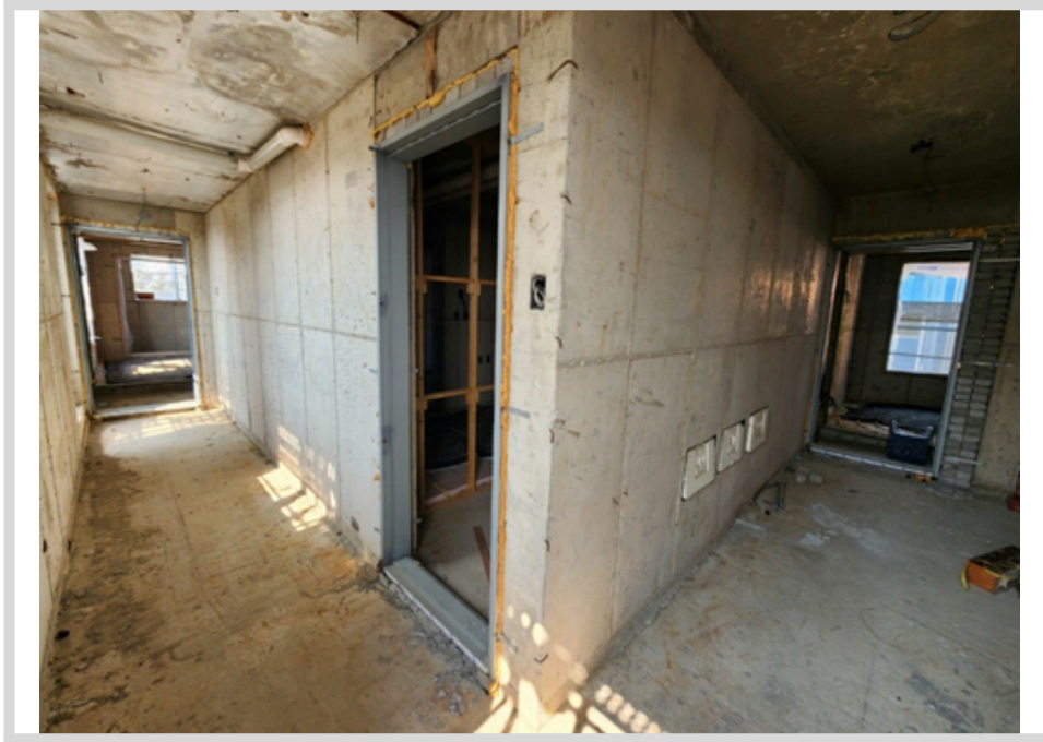
본건 3층 내부 전경
