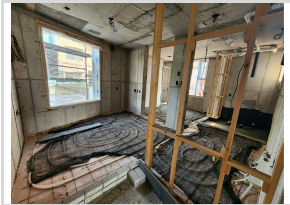
본건 2층 내부 전경
