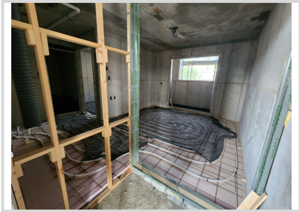
본건 2층 내부 전경
