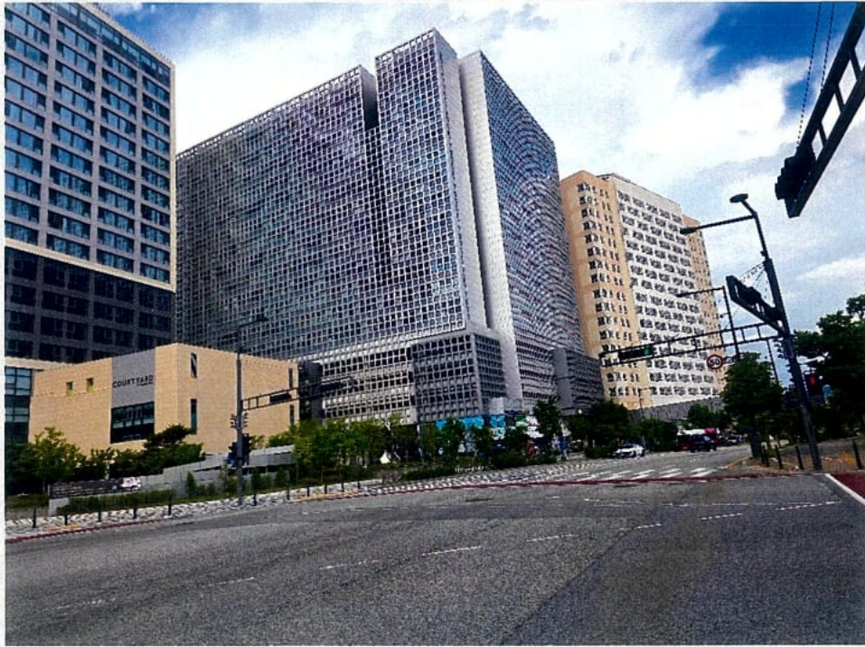
[대상물건 북서측에서의 주위 전경]
