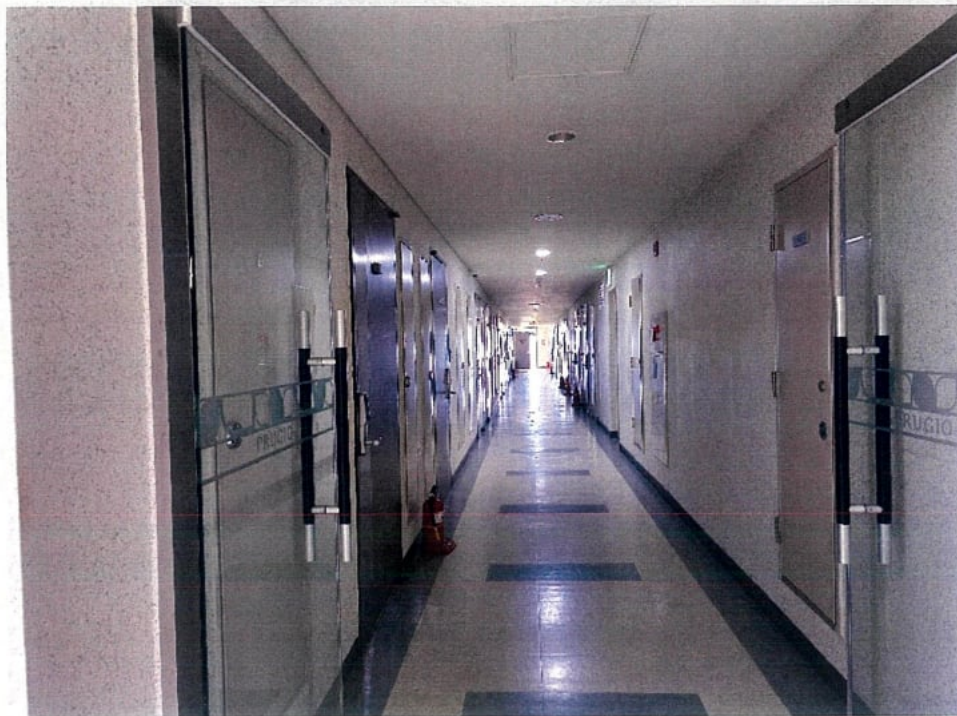
[대상물건 일련번호1 복도 전경]
