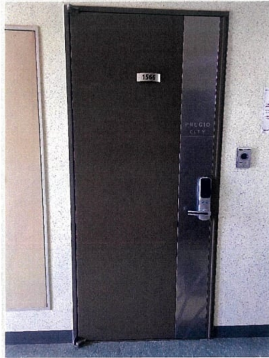
[대상물건 일련번호1 출입문 전경]
