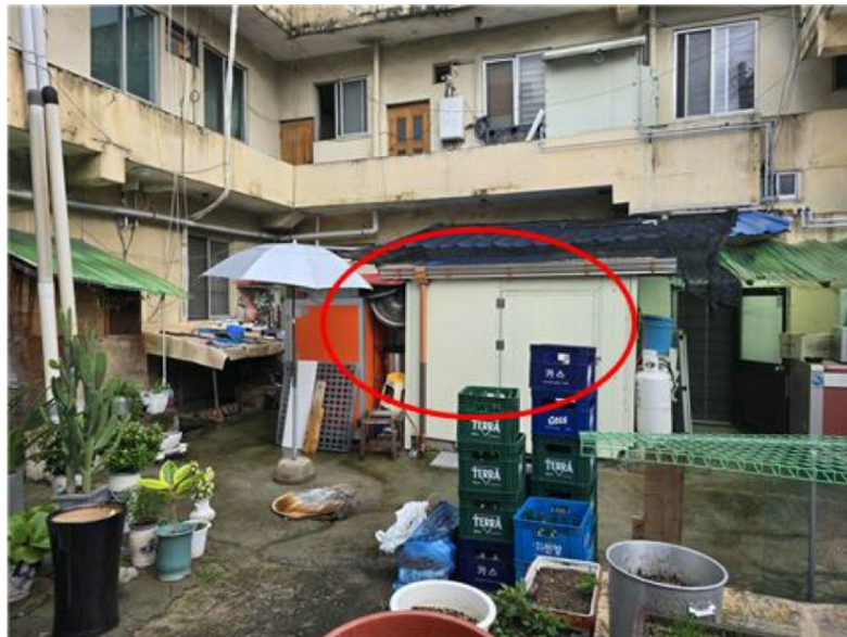
[제시의 건물 ㉠(타인소유,평가제외)]
