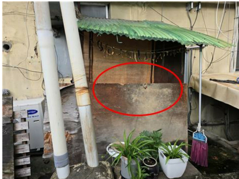
[제시의 건물 ㉡(타인소유, 평가제외)]
