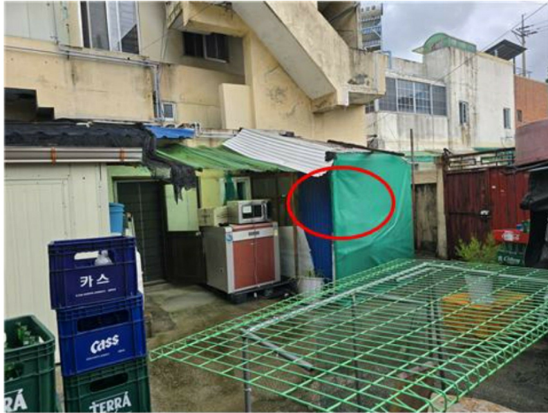
[제시의 건물 ㉠(타인소유, 평가제외)]
