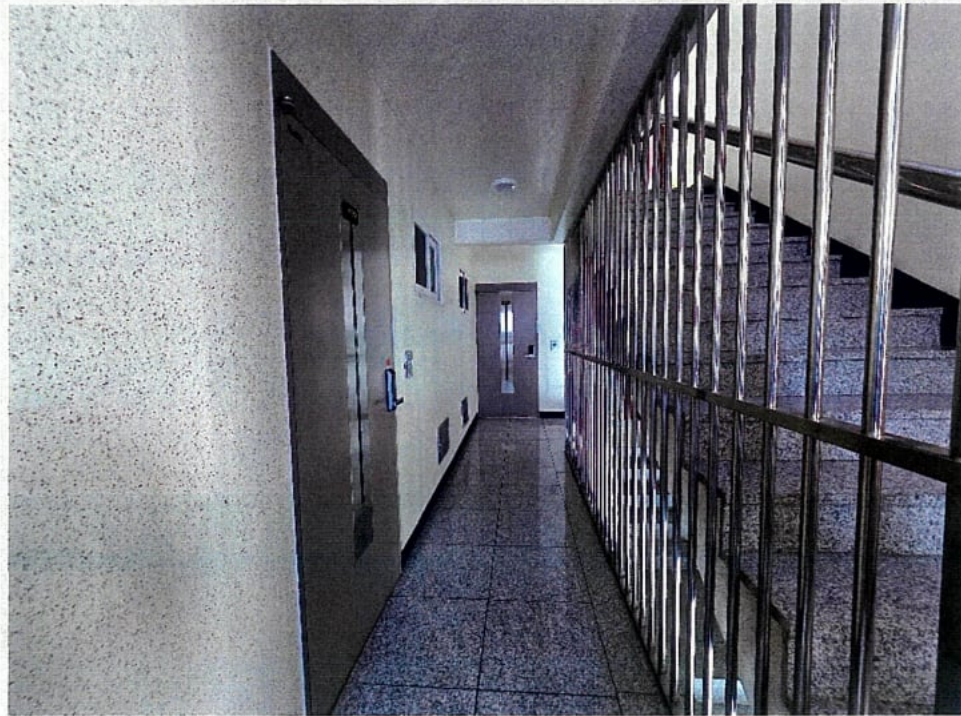
[대상물건 일련번호2 2층 복도 내부 전경]
