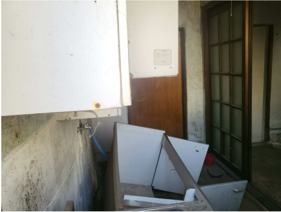
[본건 건물 1층 내부]
