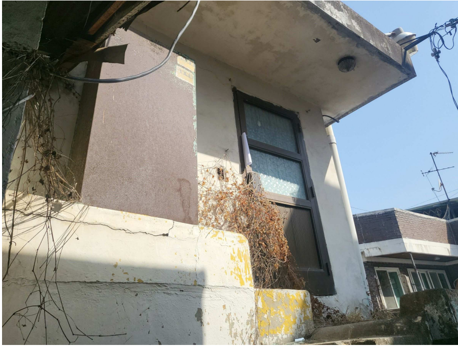
[본건 건물 2층 전경]
