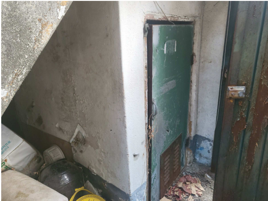
[본건 건물 1층 전경]
