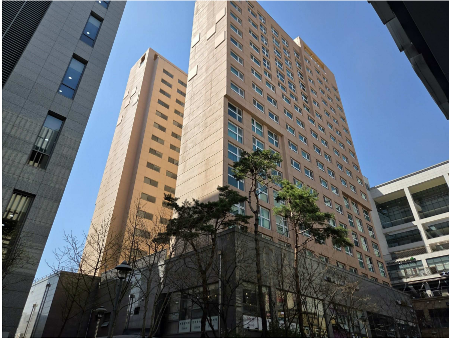
[본건 건물 전경(남동측에서 촬영)]
