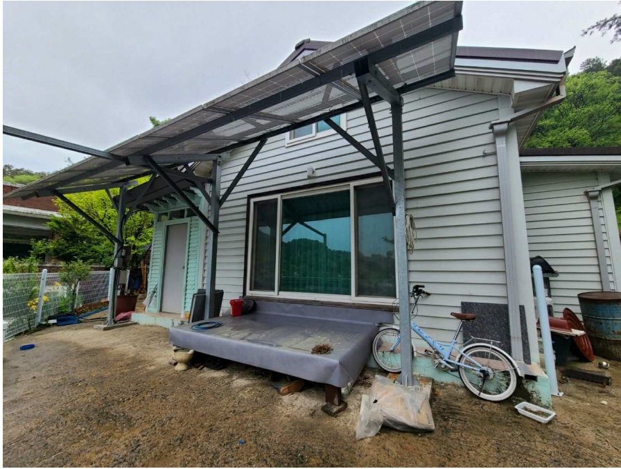
본건 건물 외부 전경
