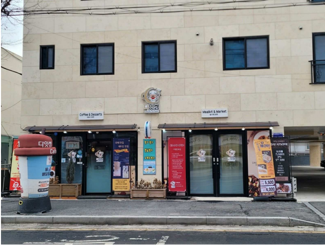
기호(2) 1층 사무소(근생) 전경
