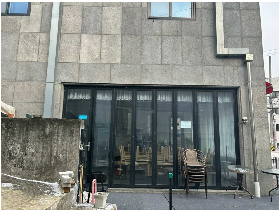
기호(3) 1층 근린생활시설
