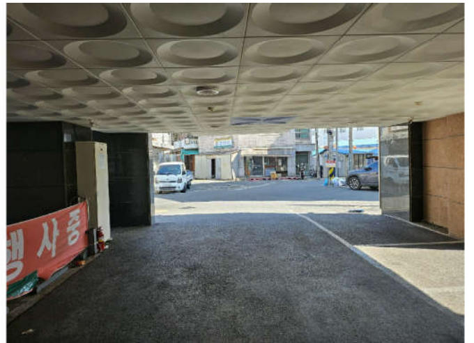
본 건물 1층 피로티주차장 주위환경
