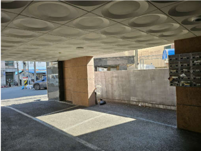
본 건물 1층 피로티 주차장 주위환경
