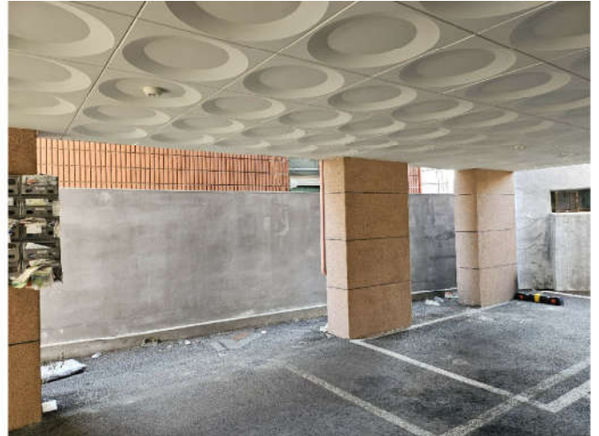
본 건물 1층 피로티 주차장 주위환경
