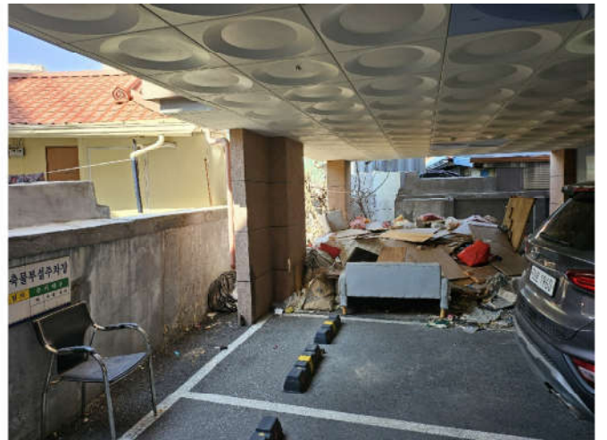
본 건물 1층 피로티 주차장 주위환경
