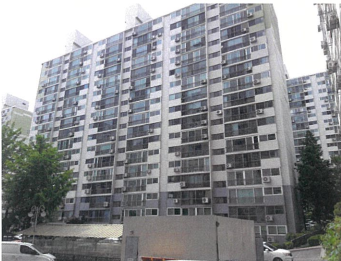
본건 남측 전경
