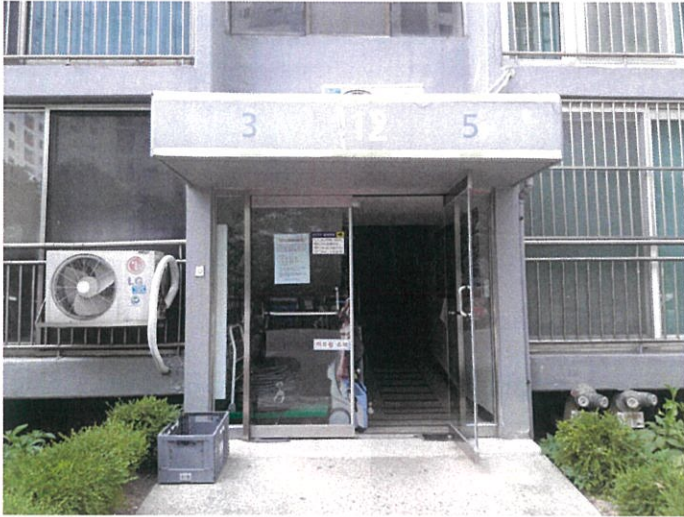
본건 1층 출입구
