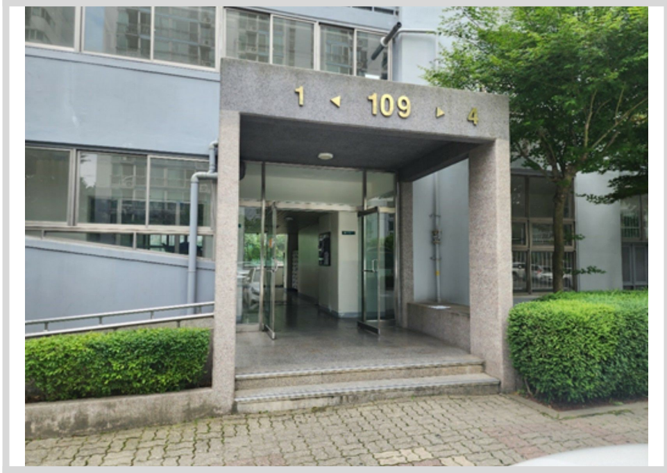
본건 1층 공동출입문 전경
