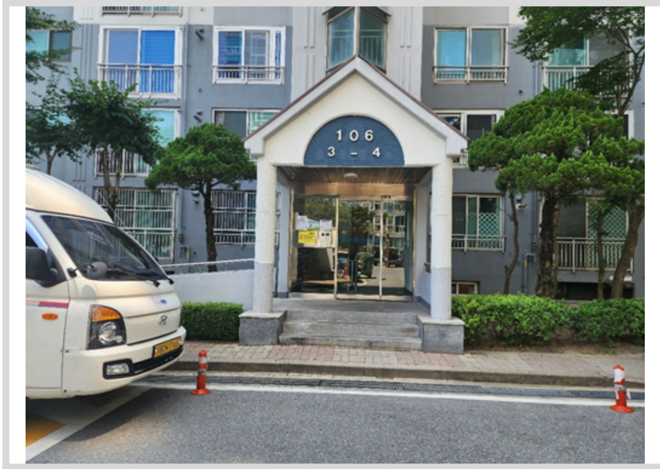
본건 1층 소재 공동 출입문 전경
