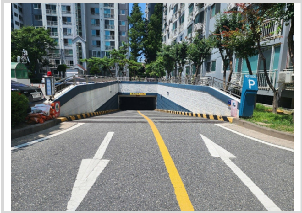
본건 단지내 지하주차장 진.출입로
