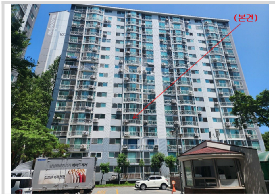
본건 전경 - 본건 남측에서 촬영
