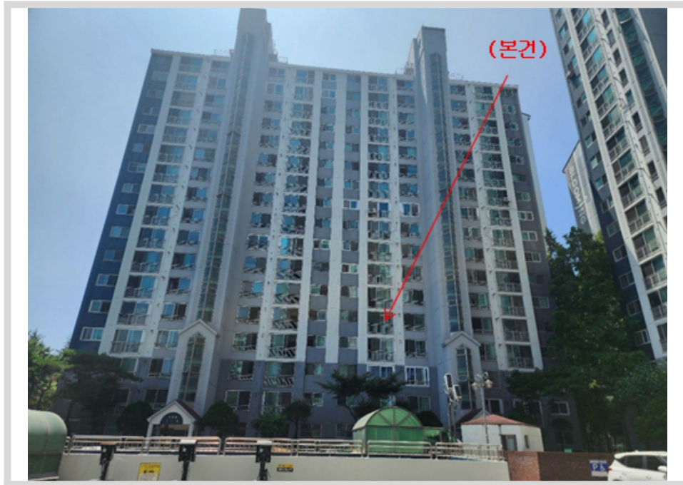
본건 전경 - 본건 북측에서 촬영
