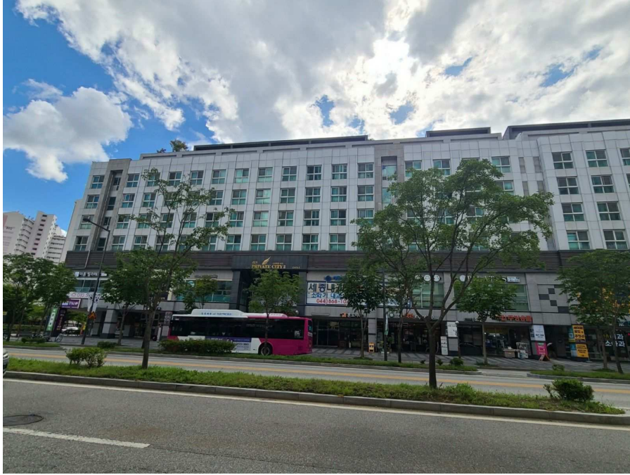
본건 건물 전면 외부 전경
