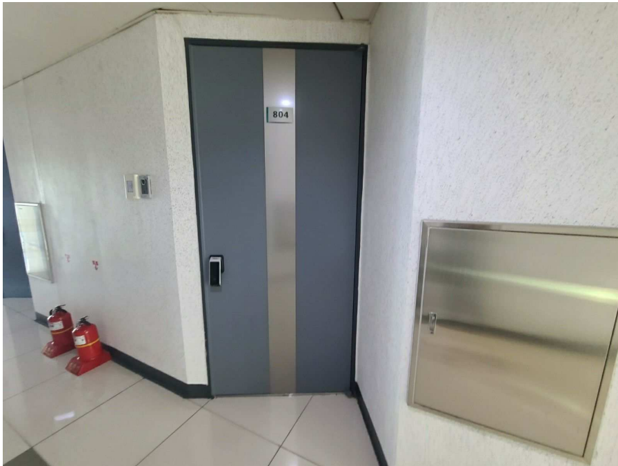
본건 제1동 제8층 제804호 출입문 전경
