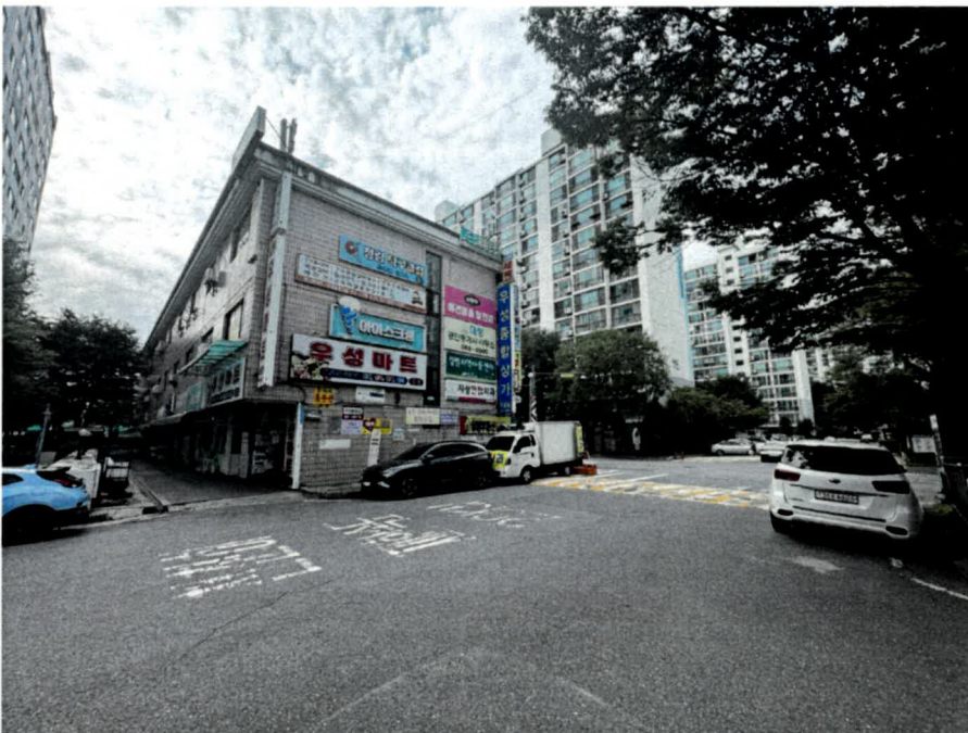
본건 상가 남동측 전경
