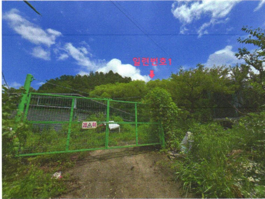
대상물건 일련번호1 전경
