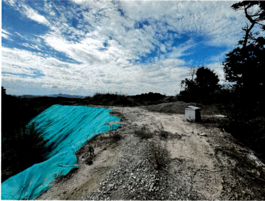
기호(1) 북동측 전경
