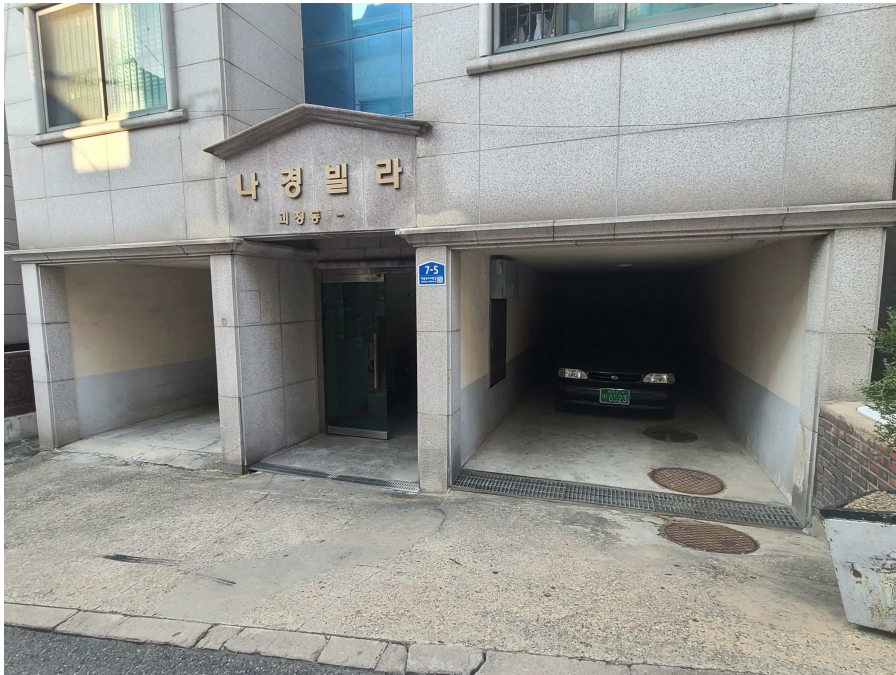
본건 건물 지상1층 전경 (출입구 및 주차장 부분)
