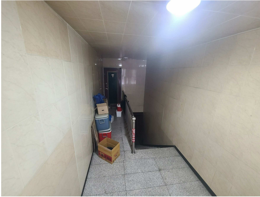
본건 건물 지상1층 전경 (다가구 주택 부분)
