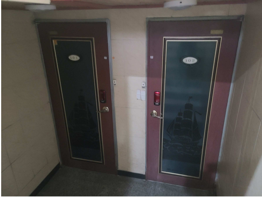
본건 건물 지하1층 전경
