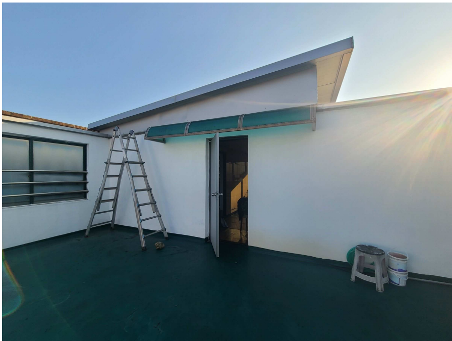
제시외건물"ㄱ,ㄴ" 외부 전경
