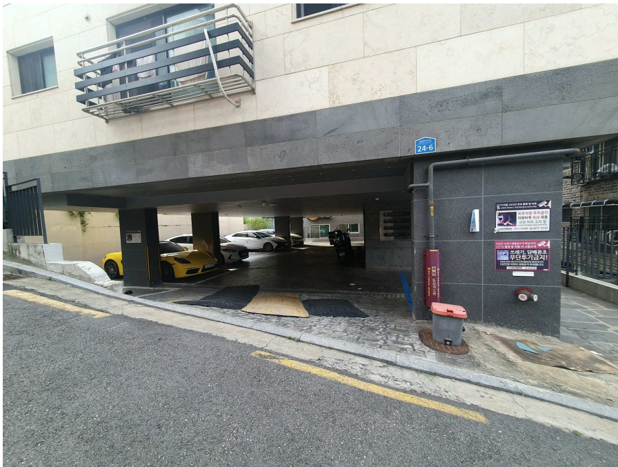
주차장 출입구 전경
