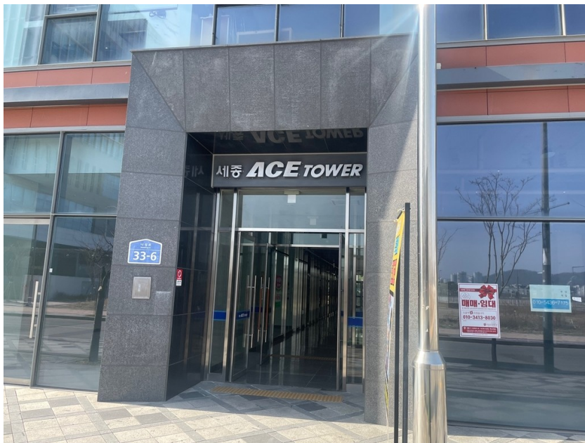
대상물건 1층 주출입구 전경
