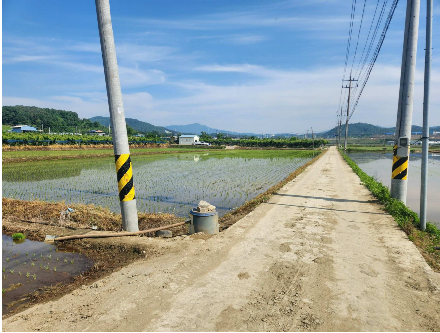
본건 전경(남동측에서 촬영)
