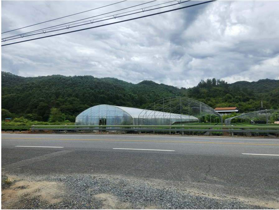
본건 전경(북서측에서 촬영)
