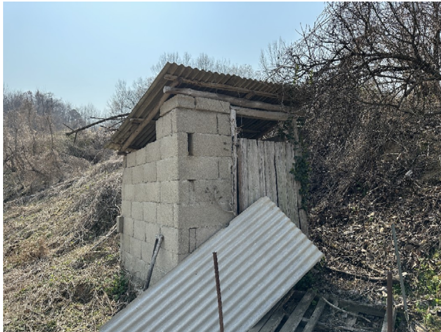
제시외 건물㉡ 전경
