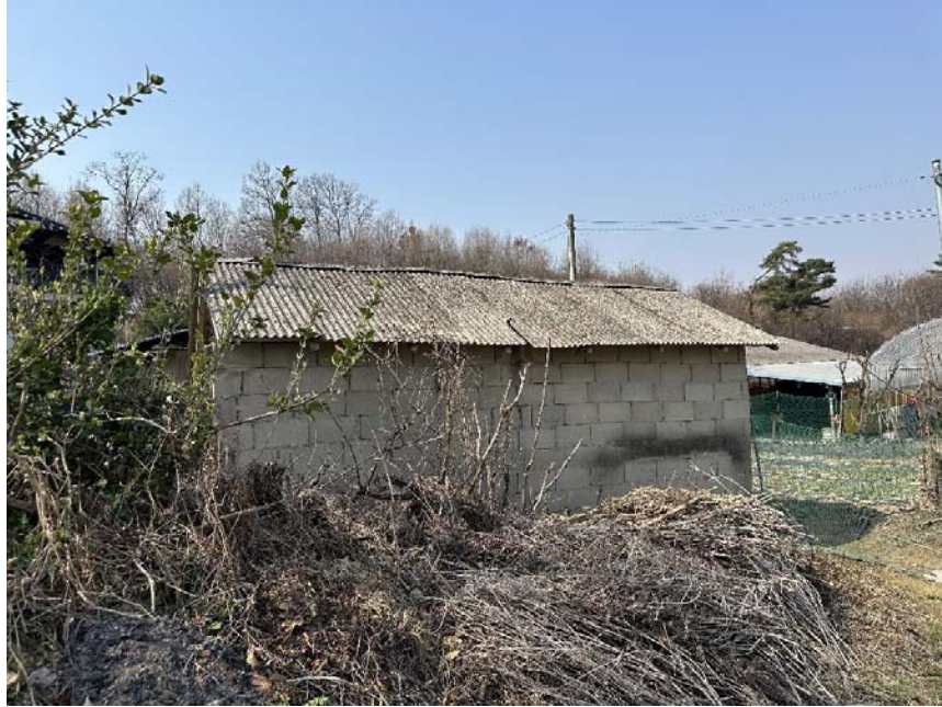
제시외 건물㉠ 전경
