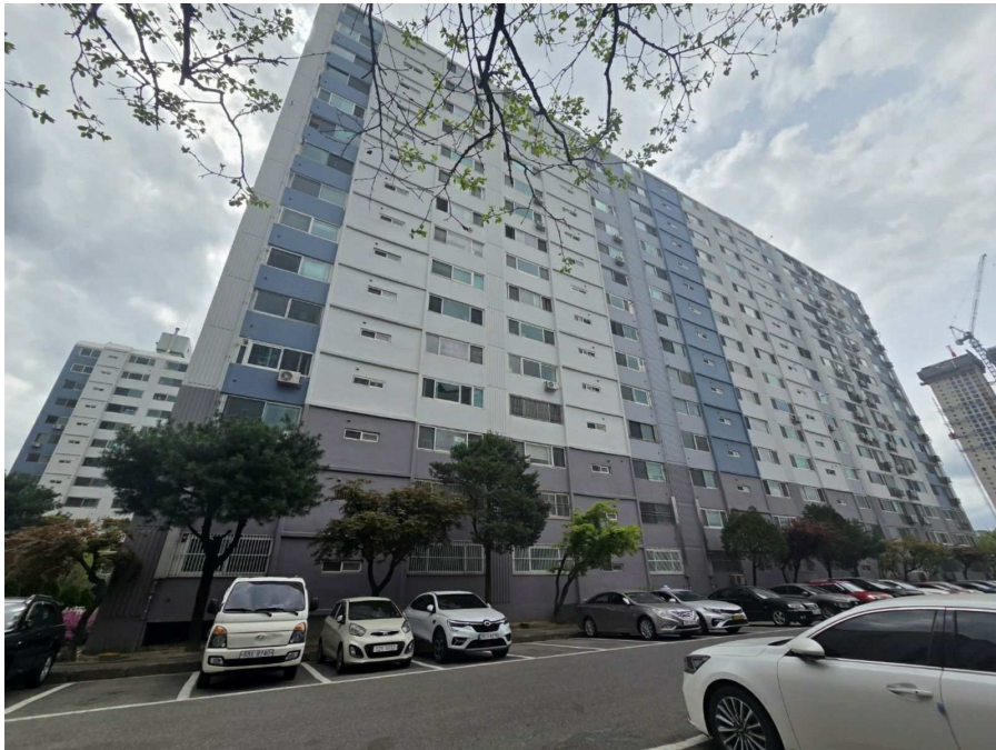
[본건 아파트 전경(동측에서 촬영)]
