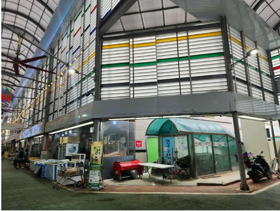
대상물건 소재 건물 전경(남동측에서 촬영)
