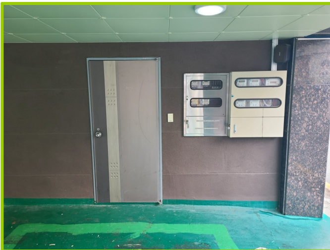
일련번호(2) 1층 호전경
