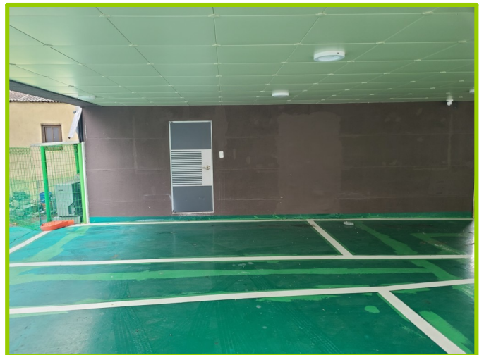
일련번호(2) 1층 호전경
