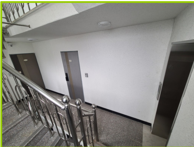
일련번호(2) 3층 호전경
