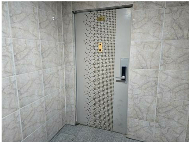
[본건 4층 누다락 주택 출입구(403호)]
