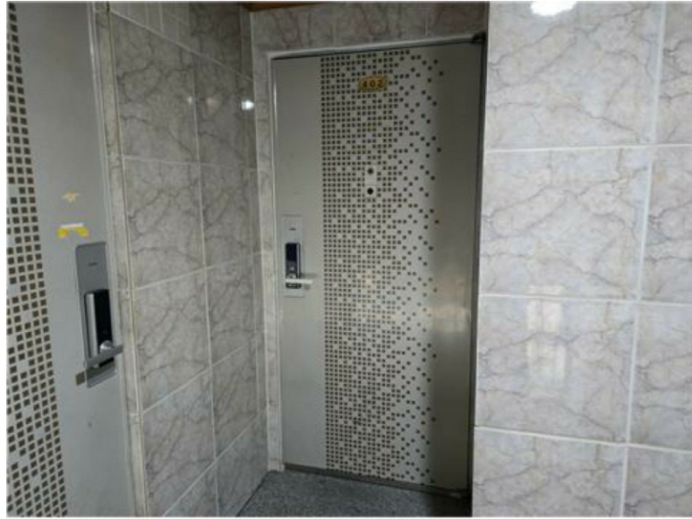
[본건 4층 누다락 주택 출입구(402호)]
