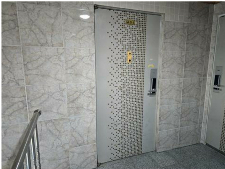
[본건 4층 누다락 주택 출입구(401호)]
