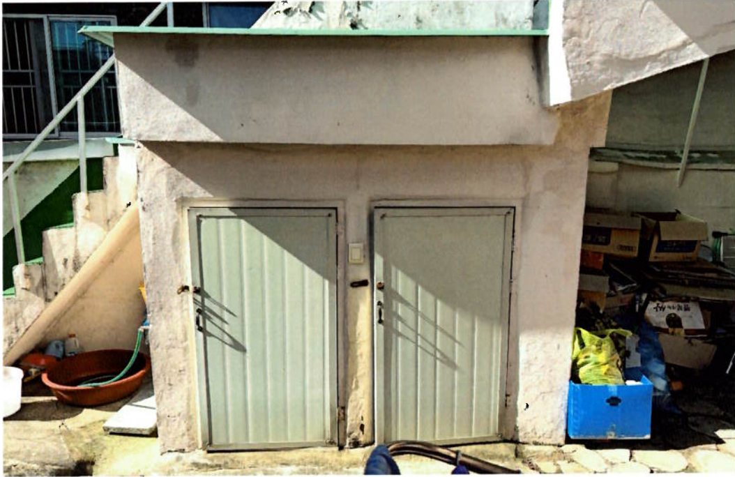
【 대상물건 일련번호(1) 부속건물 】
