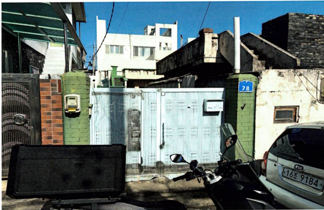
【 대상물건 출입구 부분 】
