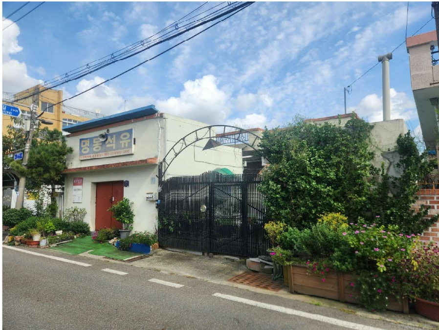
대상물건 전경(남서측에서 촬영)
