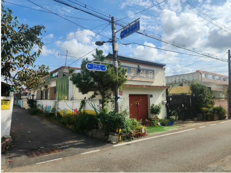
대상물건 전경(북서측에서 촬영)
