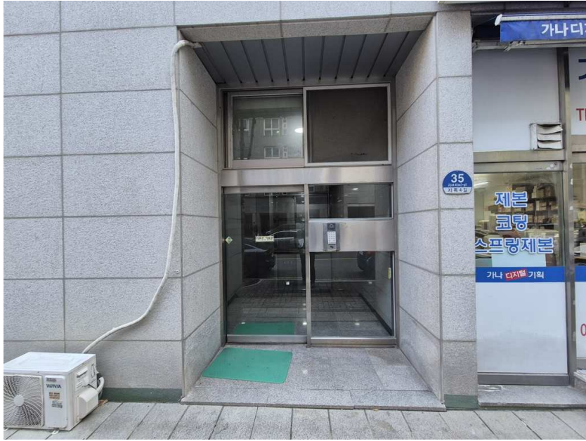
본건 공동 출입구
