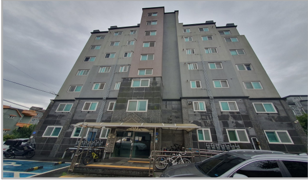
본건 건물 북측 전경
