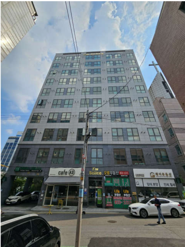
대상물건 소재 건물
