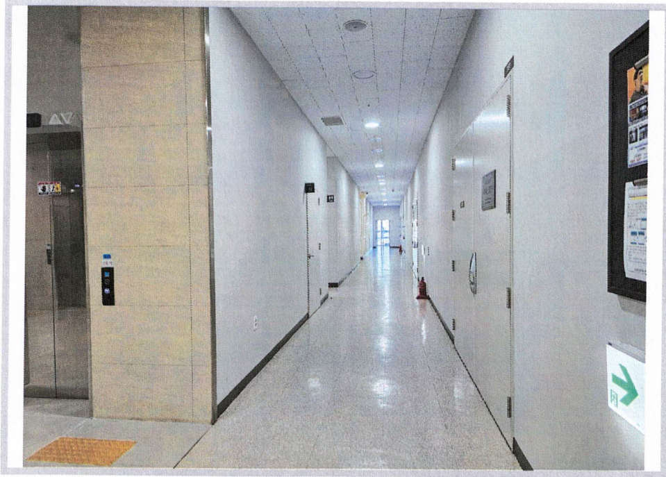
< 7층 내부 전경 >
