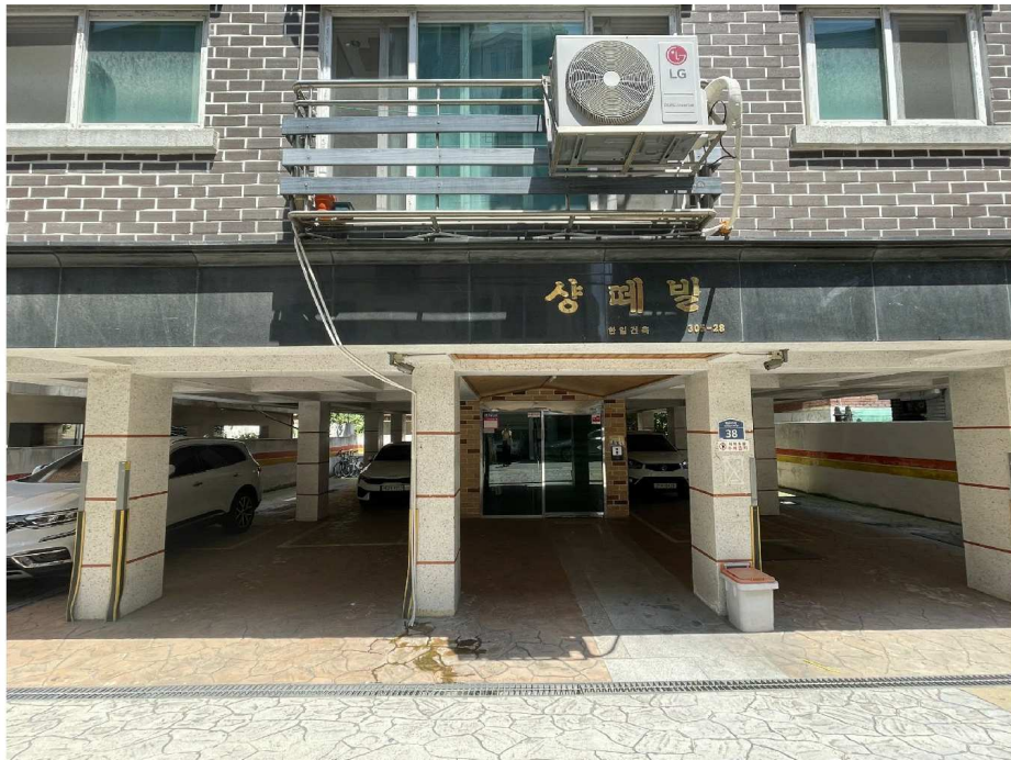
본건 건물 내 주차장전경
