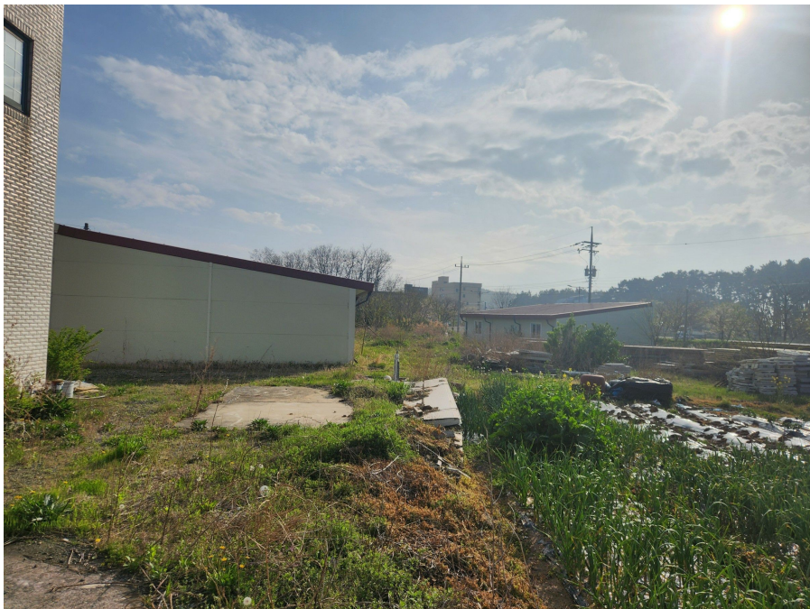
본건 기호 7), 8) 건물 (북동측 촬영)
